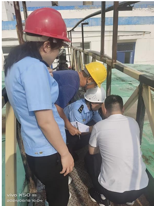
图 5 絮凝池顶部现场有害气体检测
